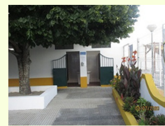
WC's para Utentes das Piscinas e zona de Lazer
